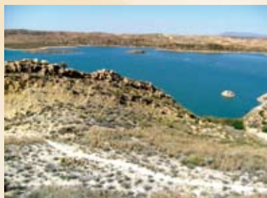
Barrage sur l'Oued Zeroud
